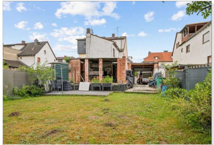
Garten mit Rohbau Anbau
