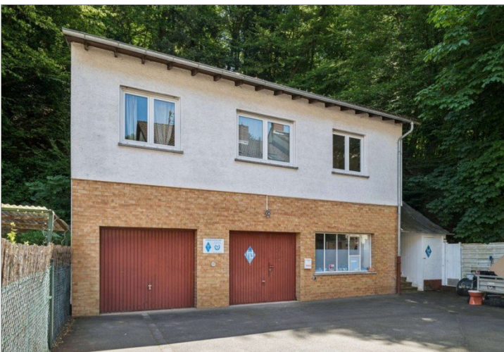
Wiesbaden Rambach Mehrfamilienhaus (26)
