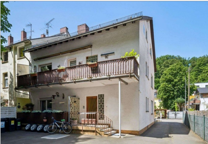
Wiesbaden Rambach Mehrfamilienhaus (1)
