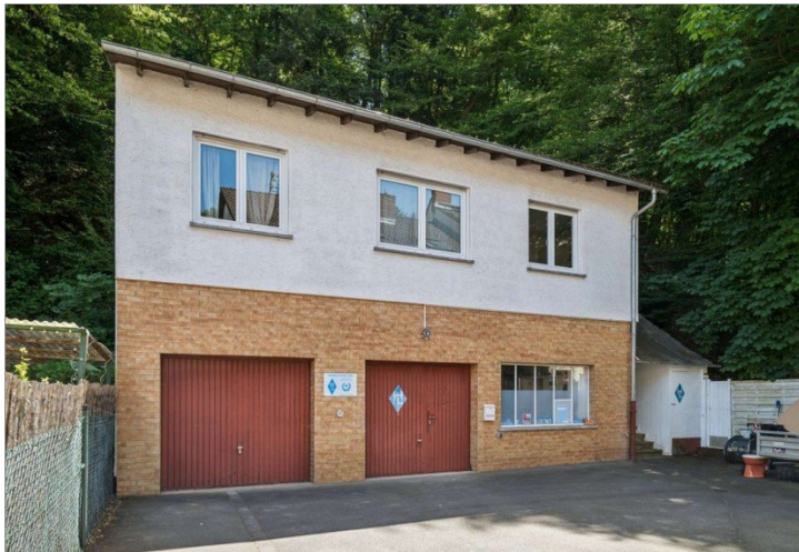
Wiesbaden Rambach Mehrfamilienhaus (26)
