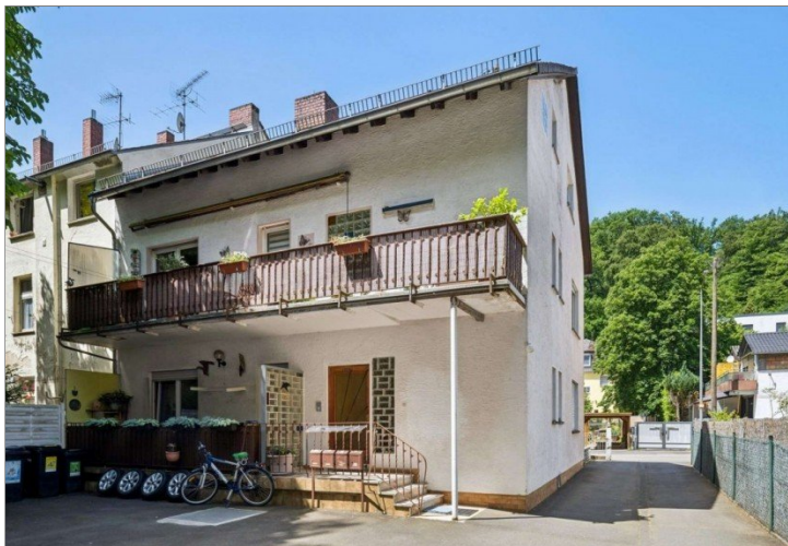
Wiesbaden Rambach Mehrfamilienhaus (1)
