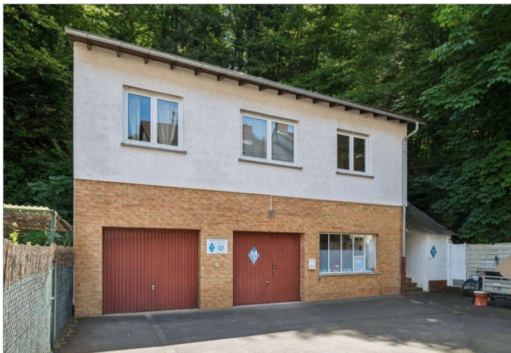
Wiesbaden Rambach Mehrfamilienhaus (26)
